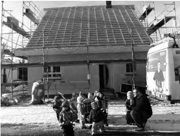
2. Tag, Das Dach ist schon drauf
